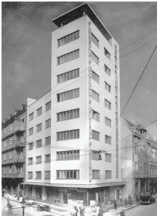
S. LÖWY, stambeno-poslovna zgrada u Masarykovoј ul., kbr. 22, u Zagrebu, 1934.
