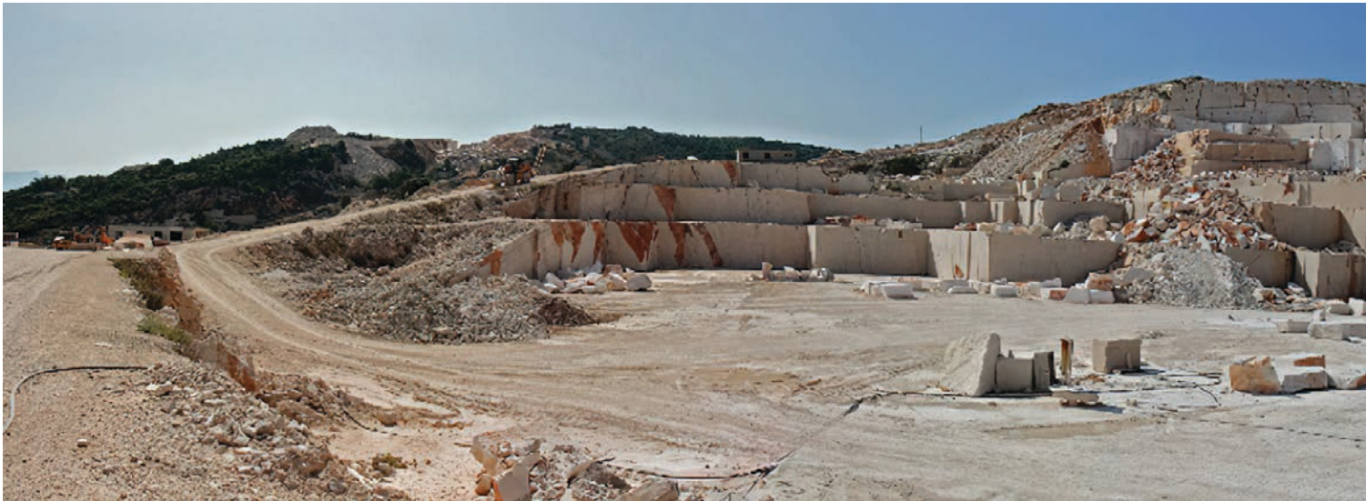
RUDARSTVO, kop arhitektonsko-građevnoga kamena Punta Barbakan, Brač
