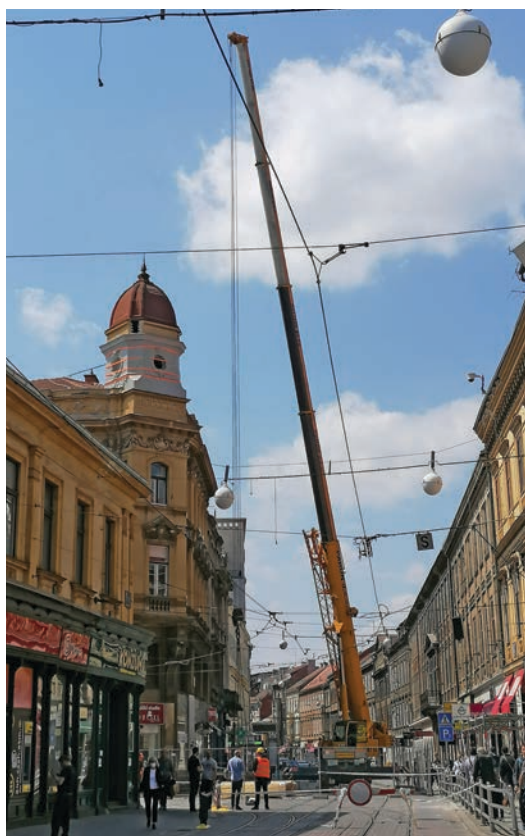
GRAĐEVINSKA OBNOVA, skidanje kupole zgrade na uglu Ilice i Frankopanske ulice nakon potresa u Zagrebu 2020.
