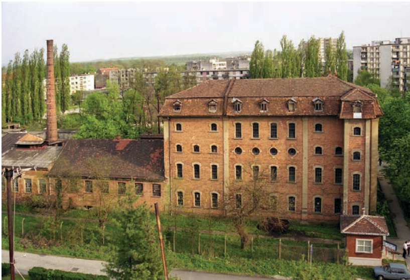
INDUSTRIJSKA ARHITEKTURA, Mustad, tvornica čavala i željezne i čelične robe (od 1951. ŽE-ČE) iz 1925., Karlovac, Gradski muzej Karlovac
