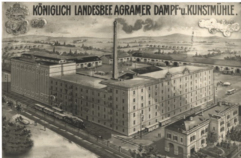
INDUSTRIJSKA ARHITEKTURA, paromlin u Zagrebu, 1914.
