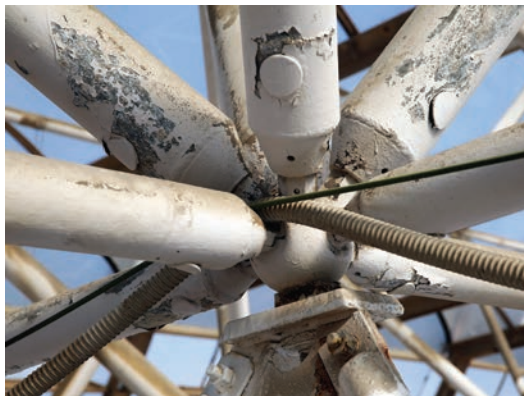
METALNE KONSTRUKCIJE, spojni element prostorne čelične rešetke sustava Mero stadiona na Poljudu iz 1979., Split foto: D. Klarić / CROPIX
