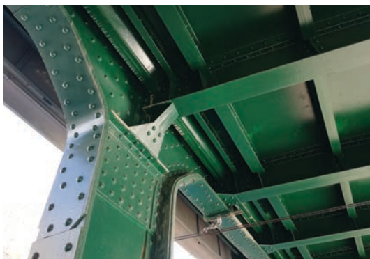
METALNE KONSTRUKCIJE, detalj željezničkog nadvožnjaka na Savskoj cesti iz 1932., Zagreb
