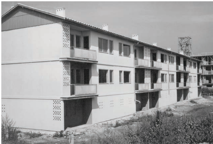
MONTAŽNA GRADNJA, zgrada građena montažnim sustavom Jugomont-L , Folnegovićevo naselje, 1960-ih, Zagreb
