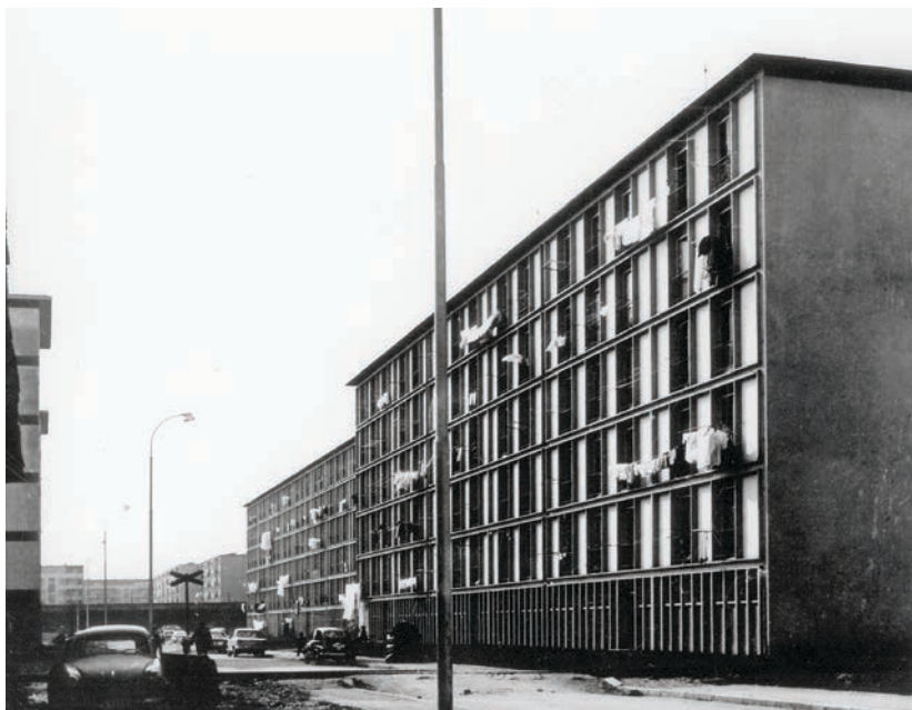
MONTAŽNA GRADNJA, polumontažni sustav izgradnje, tipizirani stambeni objekti tipa Volta u naselju Trnskom, 1960-ih, Zagreb
