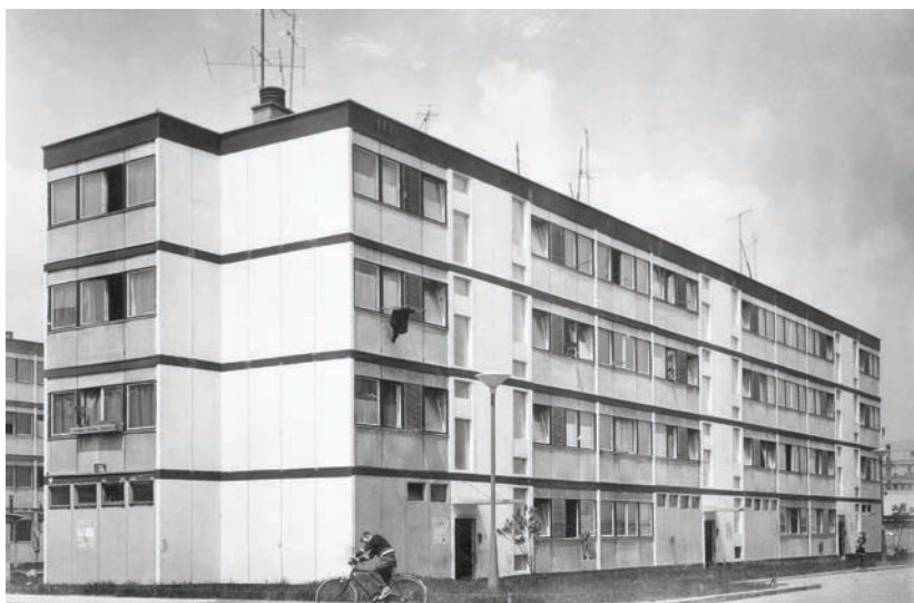
MONTAŽNA GRADNJA, zgrada građena montažnim sustavom Ju-60 , Folnegovićevo naselje, 1960-ih, Zagreb
