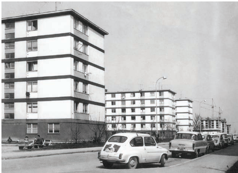
MONTAŽNA GRADNJA, polumontažni sustav izgradnje, tipizirani stambeni objekti tipa Bartolić u naselju Trnskom, 1960-ih, Zagreb
