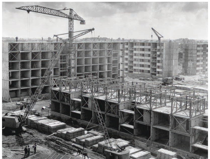
MONTAŽNA GRADNJA, zgrade građene montažnim sustavom Ju-61, 1960-ih, Zagreb
