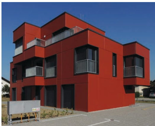
ODRŽIVA ARHITEKTURA, višestambena zgrada sustava ECO-SANDWICH s fasadnim panelima visoke energetske učinkovitosti i održivosti iz 2016., Koprivnica, arhiva Beton Lučko
