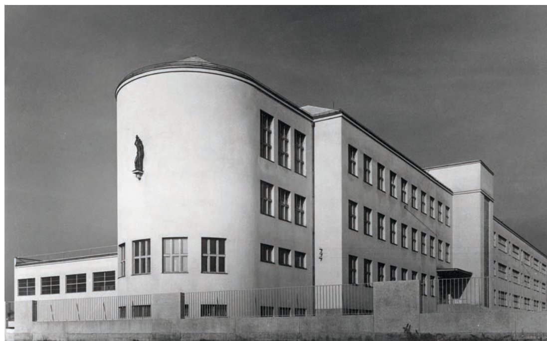
ŠKOLSKE ZGRADE, Egon Steinmann, zgrada gimnazije u Kušlanovoj ulici 52 iz 1937., Zagreb, Arhiv Tošo Dabac / Muzej suvremene umjetnosti / Grad Zagreb (ATD-13079) foto: Tošo Dabac
