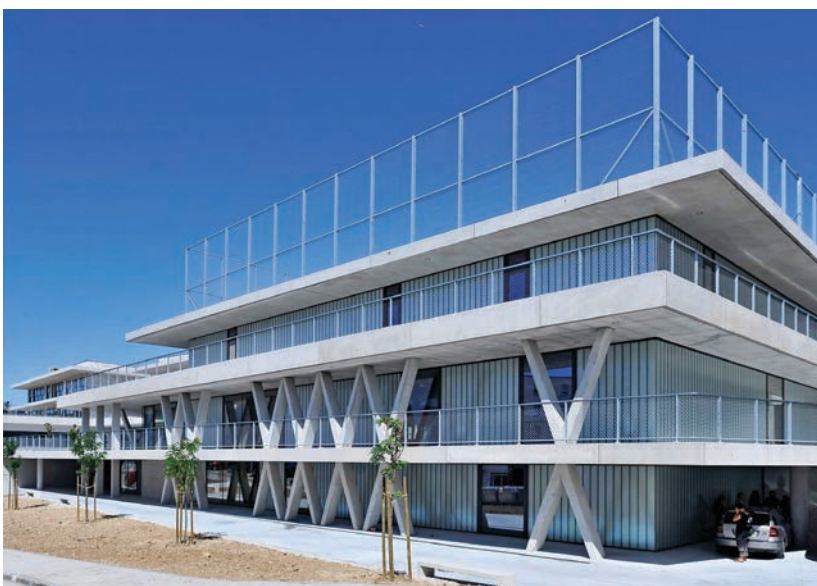
ŠKOLSKE ZGRADE, projektini ured x3m, osnovna škola u predjelu Žnjan-Pazdigrad iz 2017., Split foto: N. Vilić / CROPIX
