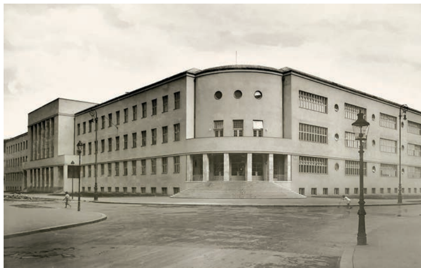
ŠKOLSKE ZGRADE, Egon Steinmann, zgrada gimnazije u Križanićevoj ulici 4–4A iz 1930–32., Zagreb
