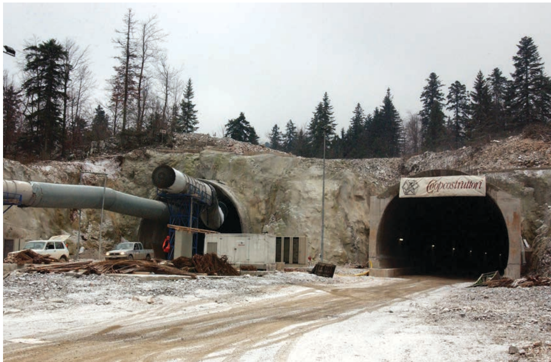
TUNELI, gradnja tunela Mala Kapela, 2003. foto: S. Vrančić / CROPIX
