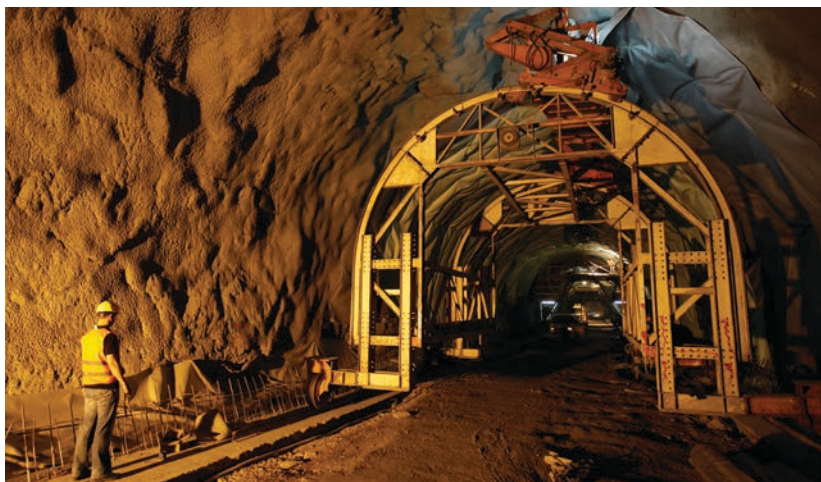
TUNELI, radovi u tunelu Mala Kapela, 2008. foto: D. Matić / CROPIX
