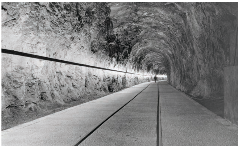
TUNELI, pristupni tunel podzemnoj strojarnici Hidroelektrane Zakućac
