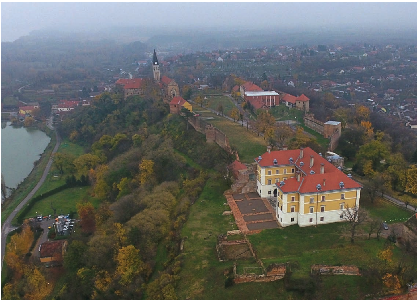
ILOK, dvorac Odescalchi nakon obnove 1969–70., foto: D. Lovrić
